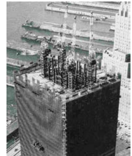
WTC 1 in der Bauphase.
