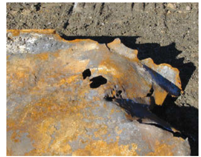
Erodierter sulfidierter Stahl von WTC 7 auf dem Schrottplatz, bevor er aussortiert und zur Untersuchung gebracht wurde
