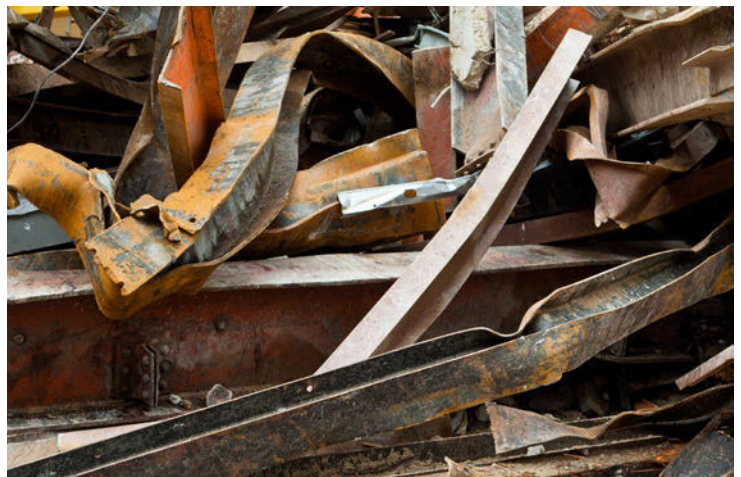
Trümmer vom Abriss eines unbekanntes Gebäudes
