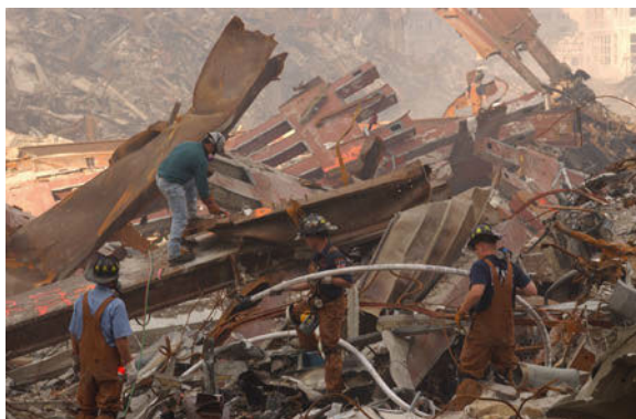
Trümmer des zerstückelten Stahlskeletts von WTC 1 und WTC 2.
