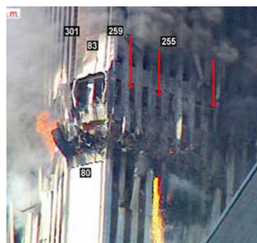
Aus WTC 2 strömendes flüssiges Metall
