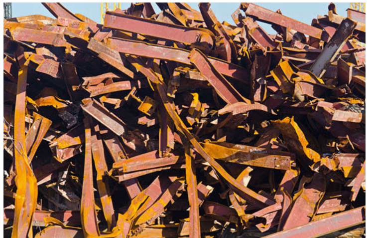
Trümmerteile vom Abriss des Grand Palace Hotel/Claiborne Towers Building, New Orleans.
