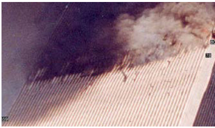
Sich nach innen biegende Außensäulen von WTC 2 zwischen den Stockwerken 77 und 83 auf der Ostseite um 9:58:55 Uhr (NIST NCSTAR 1-6, S. 178 (pdf: 260), Fig. 6-21).
